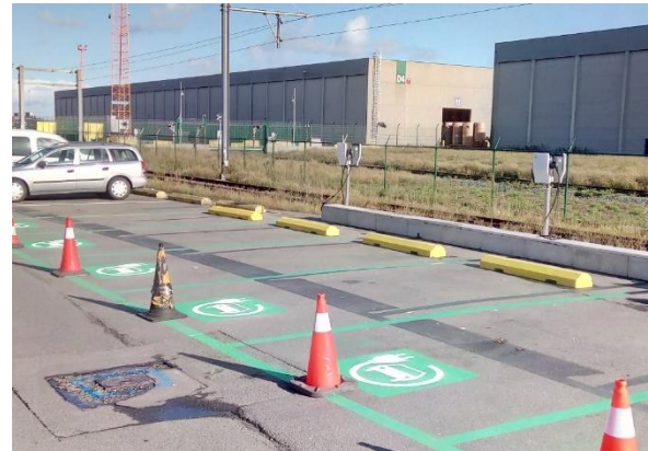
Afwerking 6 parkeervakken elektrische wagens
